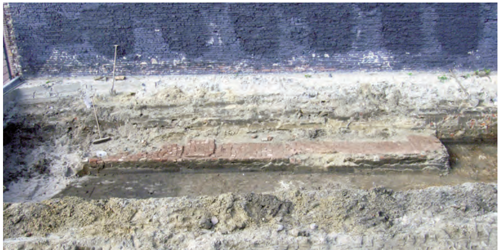
afbeelding 34, de fundering vanaf de zijkant gezien, waarbij duidelijk is dat deze onder het naastliggende pand (d'Eersteling, Grote Koppel 7) doorloopt.
